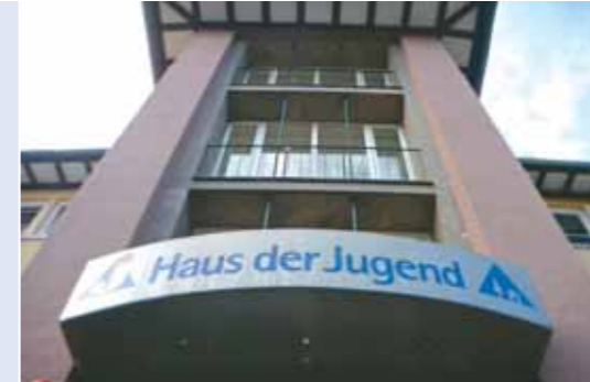
Francoforte sul Meno ostello Haus der Jugend : l'ingresso
