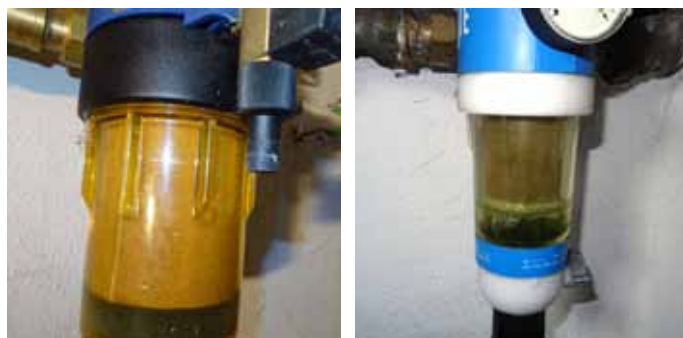
Abb. 2–3: Repräsentative Beispiele für verdreckte Hauptwasserfilter
