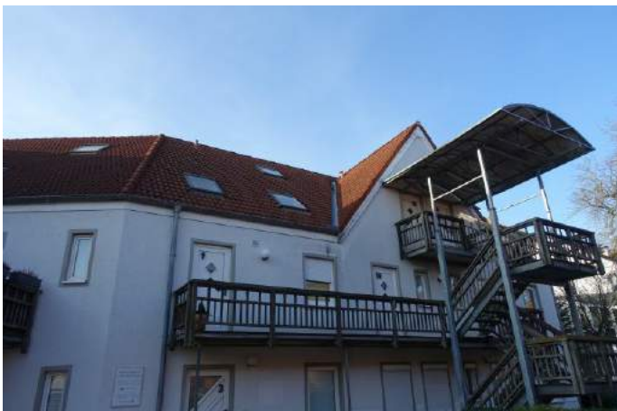
Aussenansicht Wohnung oben links
